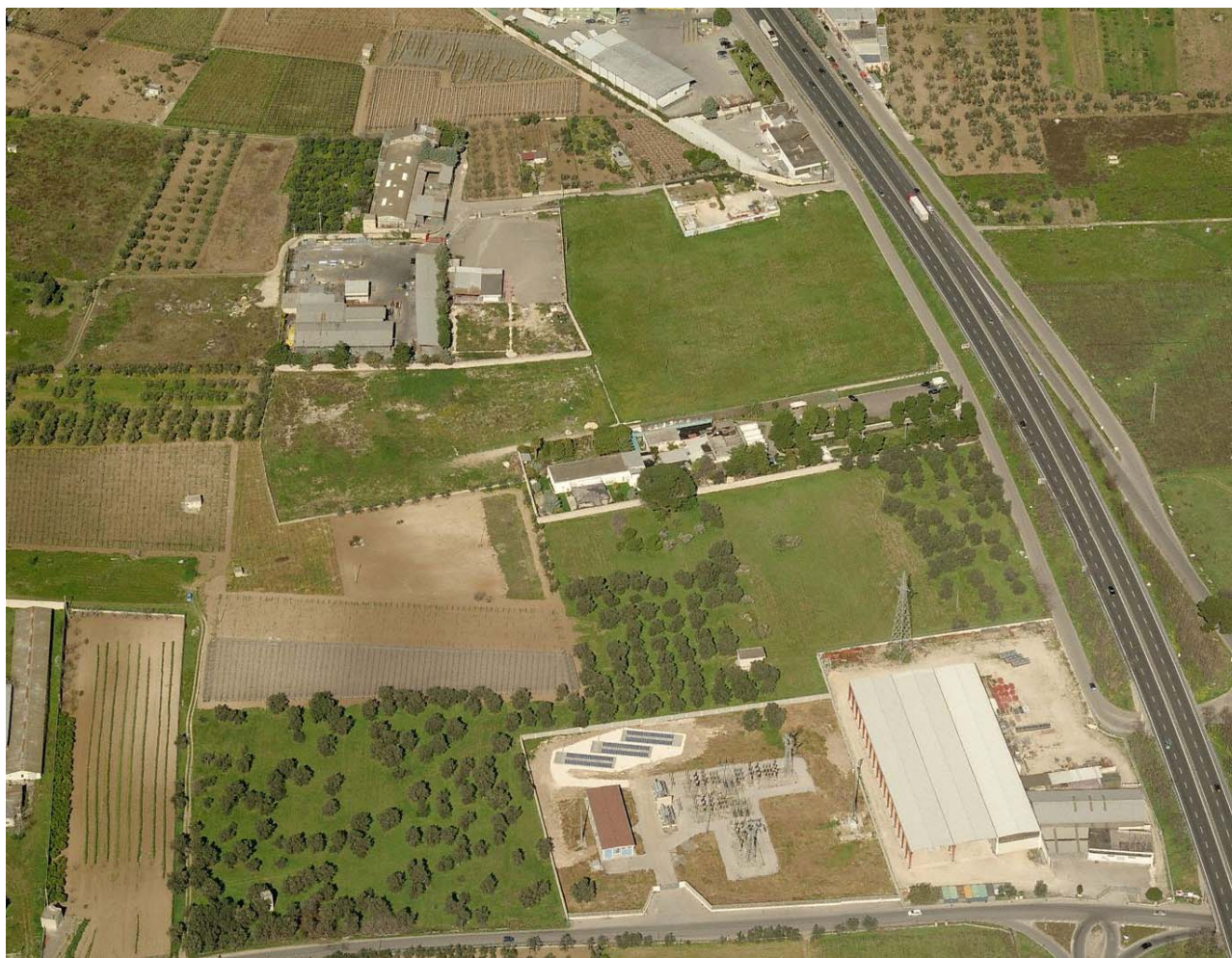
Vista aerea da sud dell'area di intervento.
